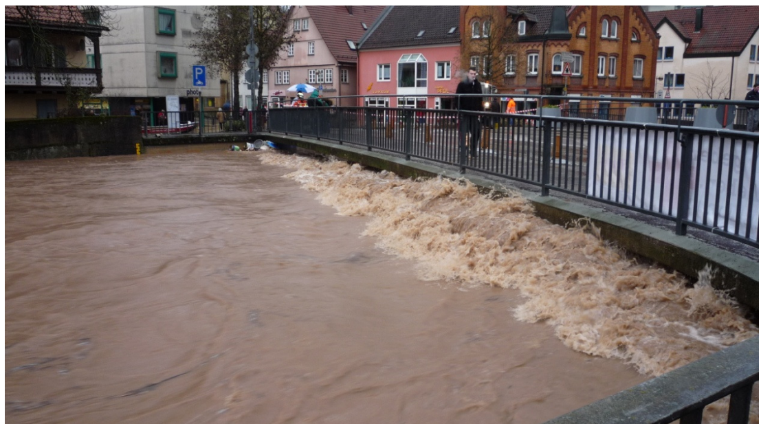
Abbildung 2: Bild einer eingestauten Brücke
